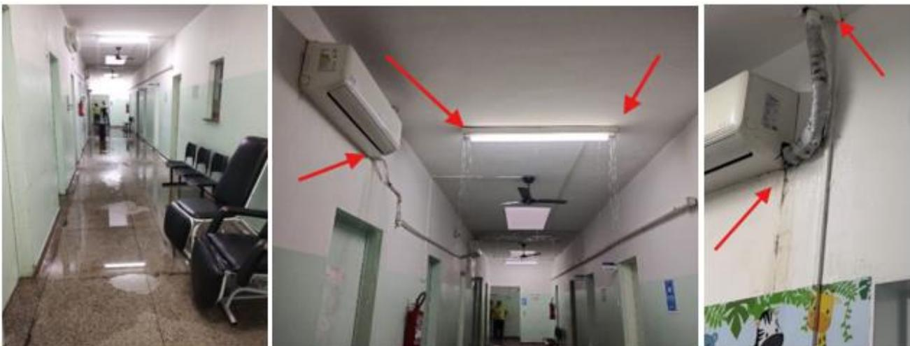
Tivemos que fechar a classificação 1, pois estava com goteiras e água caindo pelo teto e também pela saída do ar condicionado. O corredor da Pediatria estava completamente alagado, vazando água tanto pelas
