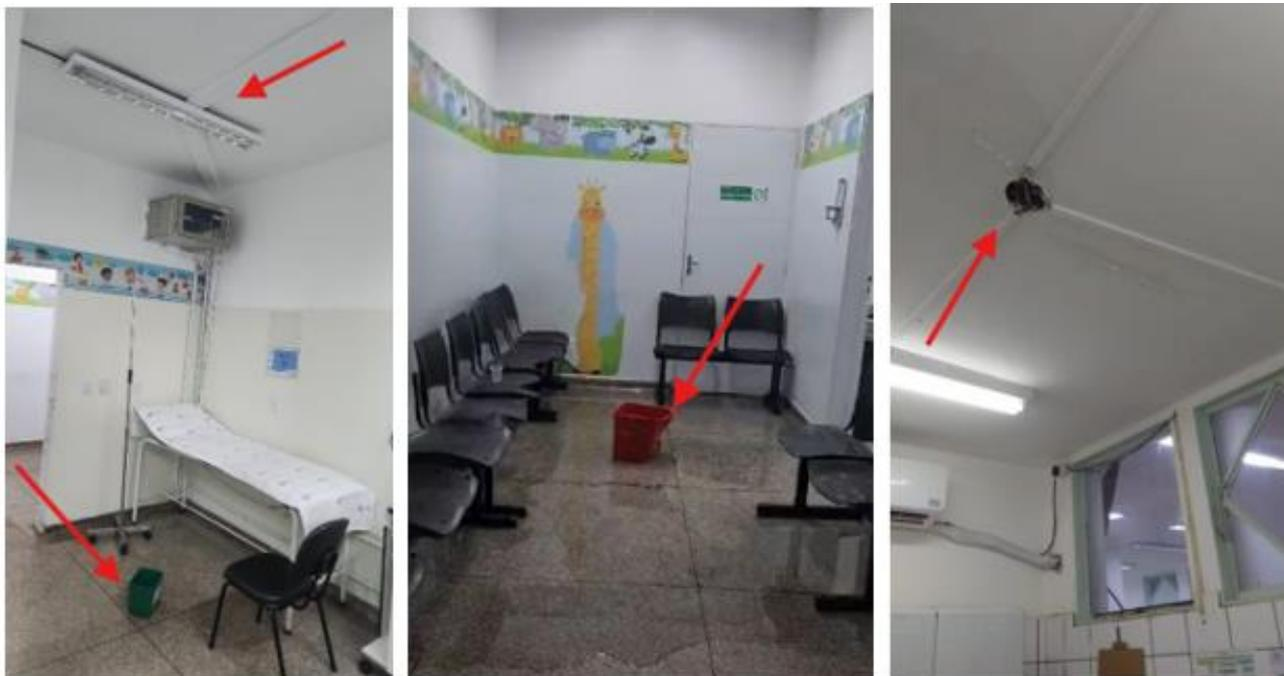
No dia 05/11/2024 nos deparamos novamente com chuvas intensas, fomos surpreendidos com novos focos de goteiras nos seguintes locais: Espera de reavaliação e também acesso ao raio x completamente alagado, com muita vazão de água pelas lâmpadas.
