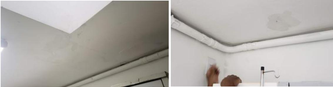
Após contato, refizeram a manta asfáltica, e o concreto. Fizeram ainda um teste de estanqueidade de 5 dias, e não teve vazamento, no entanto faremos o acompanhamento e verificação no período chuvoso com previsão de outubro a março na região de Ribeirão Preto. Seguem as fotos da pintura do local realizadas em 10/06/2024.
