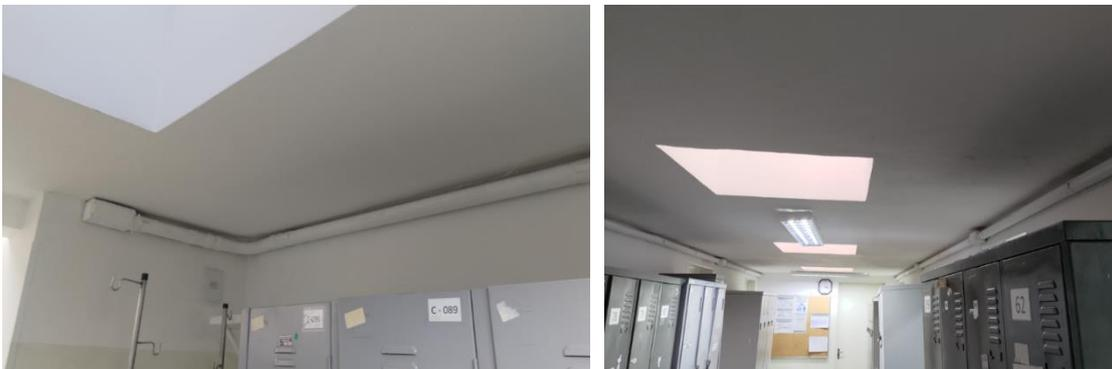
No dia 25/10/2024 durante as chuvas muito fortes com temporais foi constatado que vários setores foram afetados devido a “goteiras” com saída pela tubulação das lâmpadas e ductos de ar condicionado, conforme imagens abaixo. Nesta ocasião vários setores foram afetados.
